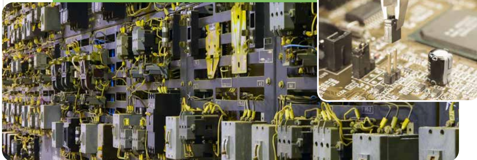
Nettoyage de contacts électriques avec technique dite "sèche".
